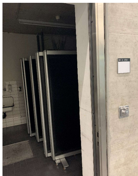
Dock E, G2, Raum M1-2-453
