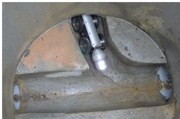
Mit einer Kamera werden auch unzugängliche Kanäle regelmässig auf ihren Zustand überprüft.
