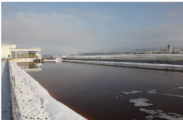
Die Stapelbecken für stark belastetes Enteiserabwasser
