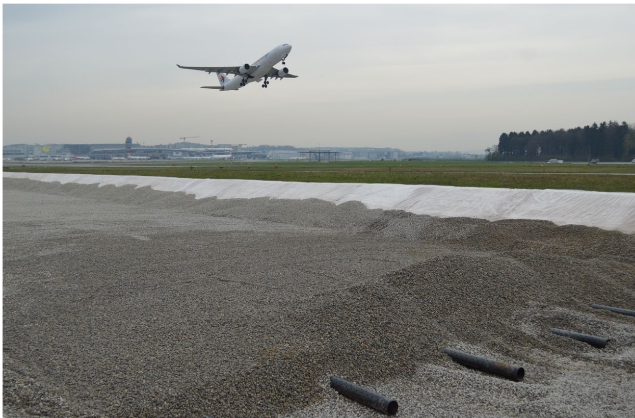
Retentionsfilterbecken nördlich der Piste 10/28 im Bau.
