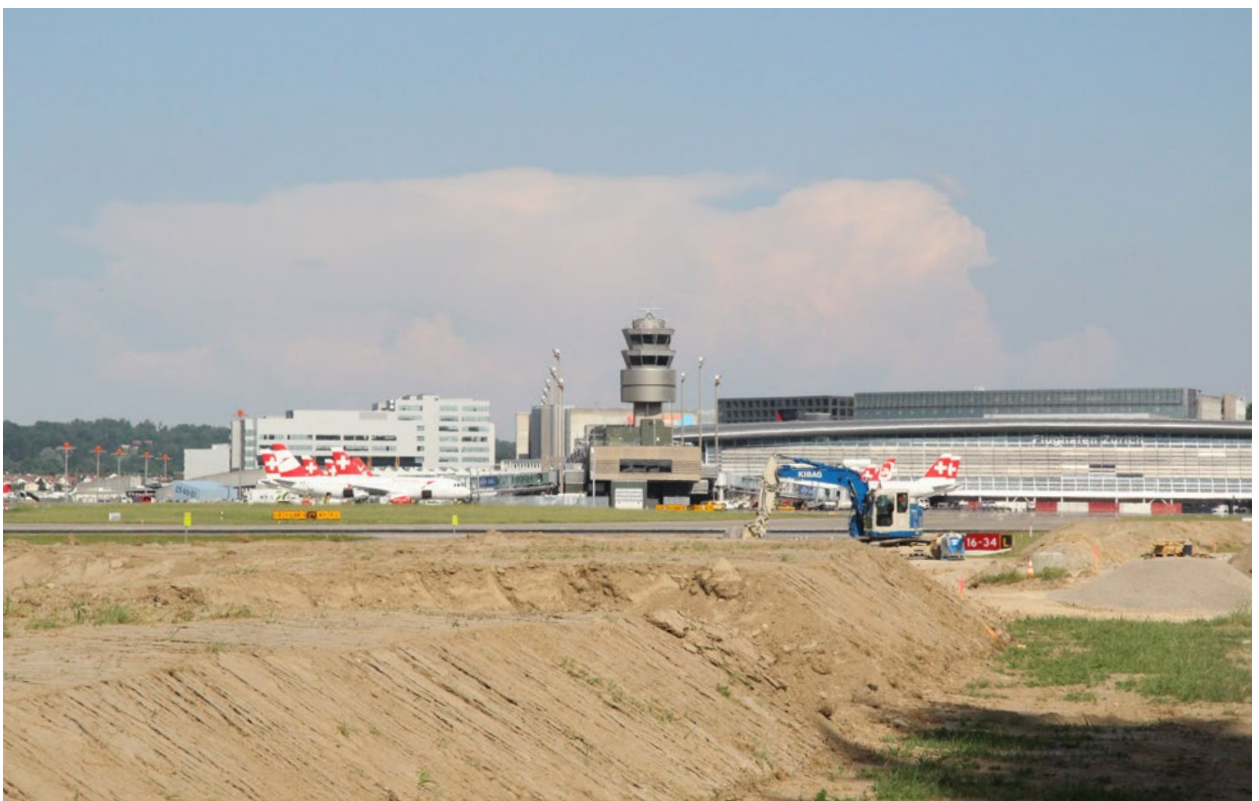
Bauarbeiten werden von Umweltfachpersonen begleitet.
