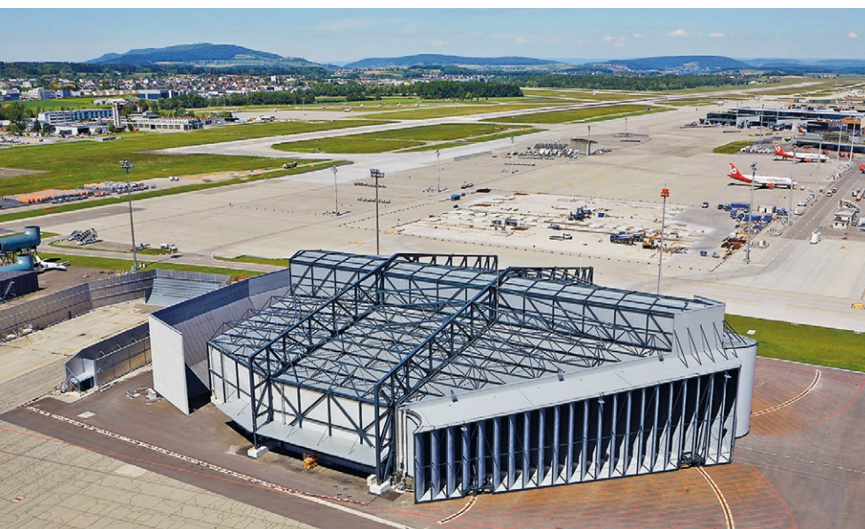
Blick auf die mit modernster Technologie ausgestattete Schallschutzhalle.
