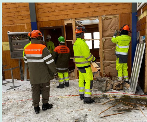
Gemeinsame Instandstellungsarbeiten am Gebäude
