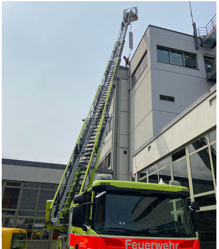
Installation einer neuen Sirene auf dem Werkhof Gebäude W1
