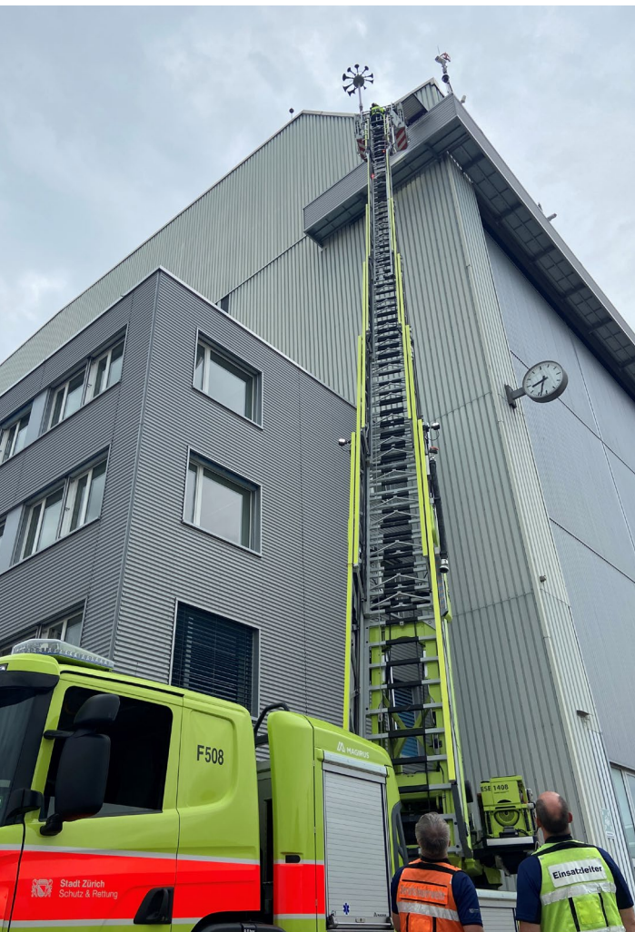
Mit Hilfe einer Drehleiter können die Demontage-Arbeiten in rund 30 Metern Höhe beginnen.
