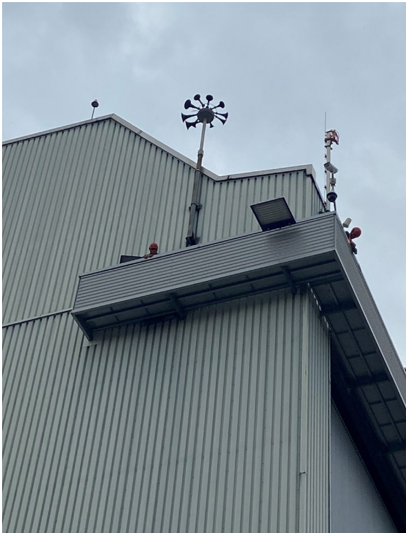
Die alte, pneumatische Sirene auf dem Dach des Gebäudes T1 Werft
