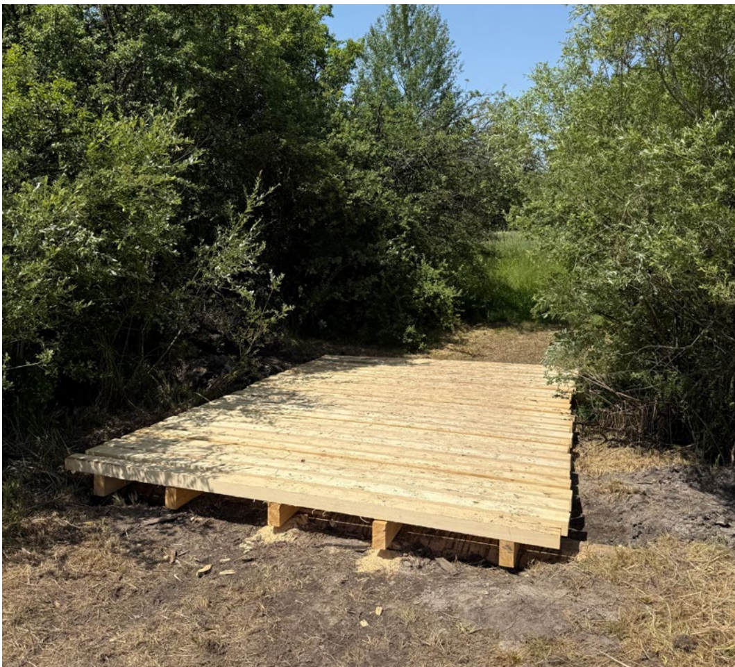
Neue Brücke über dem Sumpfgebiet
