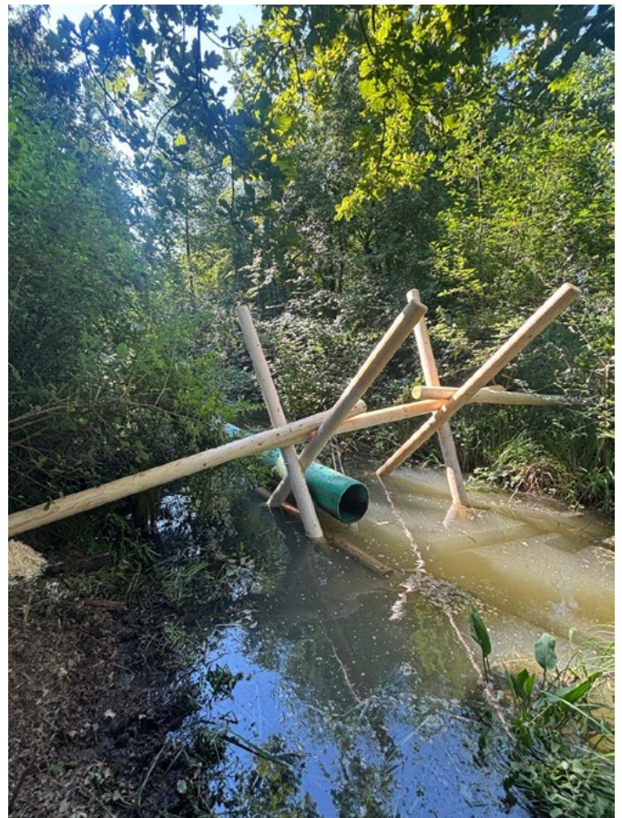
Neues Rohr, um den Wasserstand im Himmelbach zu regulieren
